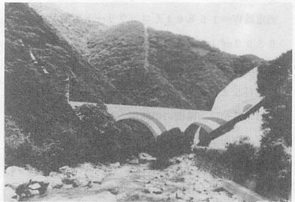
コンクリートアーチ橋 (九州縦貫自動車道)
