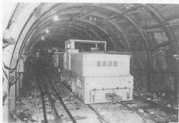
三瀬トンネル
