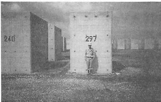
写真-2 本体ブロック
