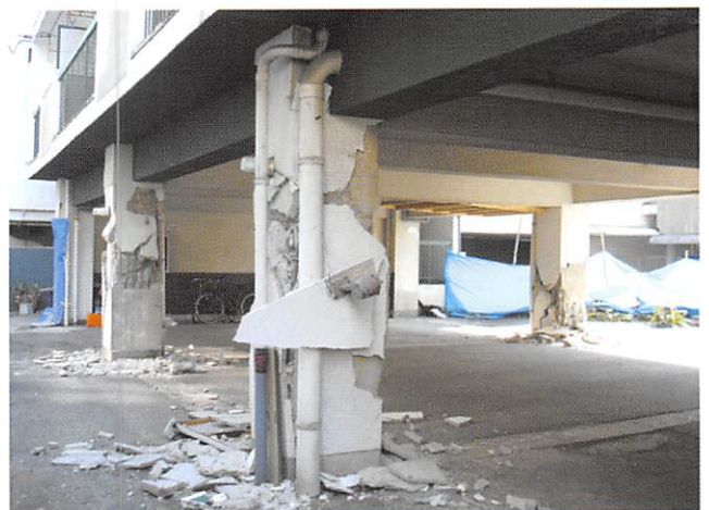
写真-9 ピロティ形式の5階建てアパート（竣工1966年）、大名1丁目
