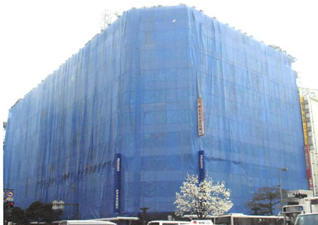
写真-7 多数の窓ガラスが割れて落下したビル
