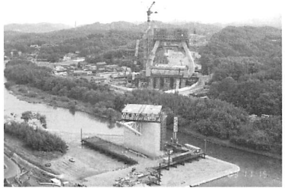
写真7. 施工状況（A1側より撮影）
