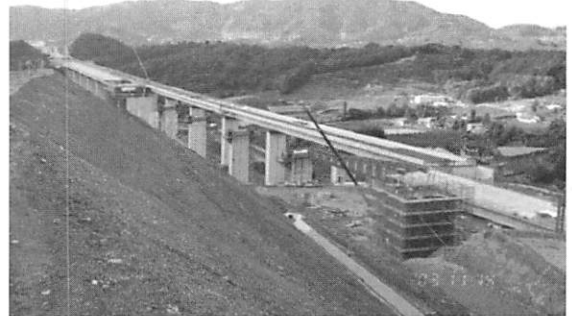
写真2. 押し架設の状況
