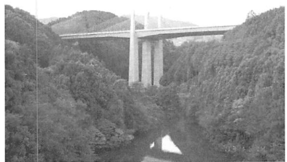
写真3. 都田川橋の全景
