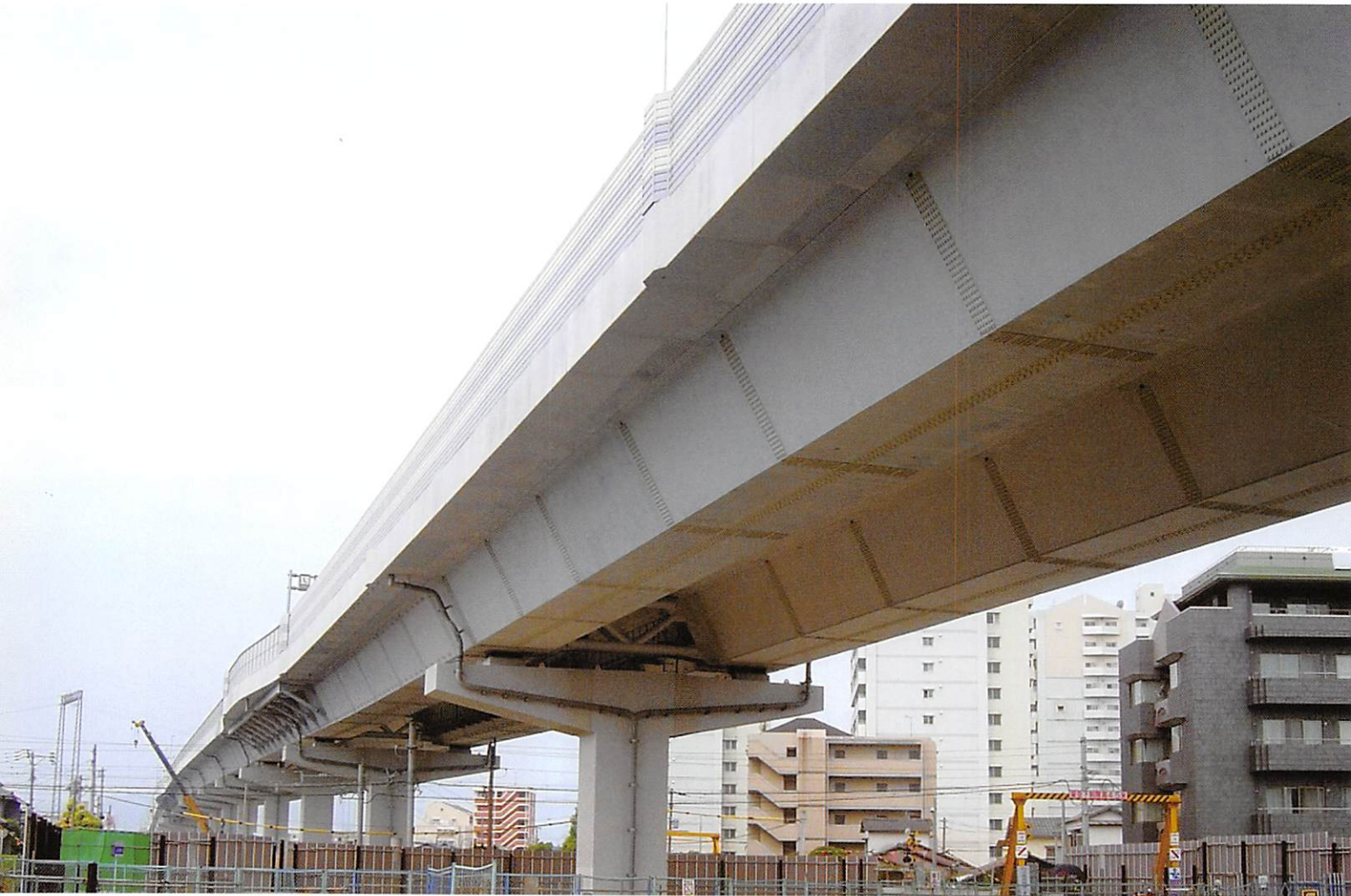
福岡高速5号線の多径間連続鋼開断面箱桁橋
