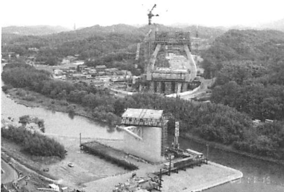
写真5. 施工状況（P1主塔より撮影）
