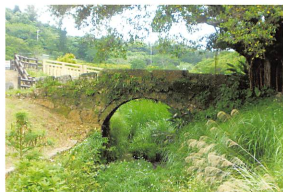
ヒジ川橋全景
