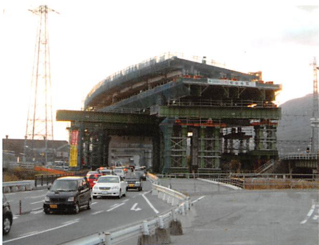
写真-3 JR 鹿児島線跨線部の送り出し状況
