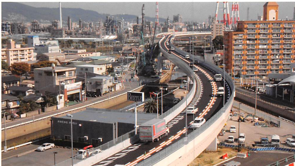
写真-10 黒崎バイパス（開通後の陣原ランプ）
