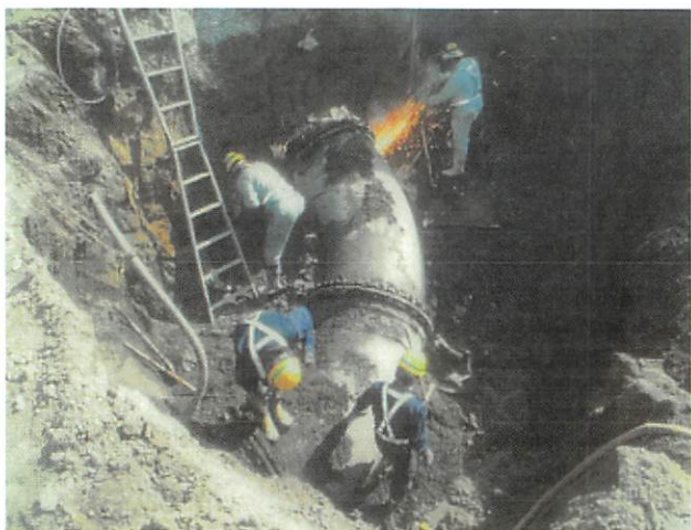
写真-4 発見された埋設管
