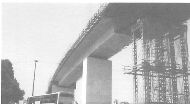
図-2. 大牟田高架橋
