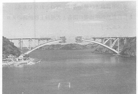
外津橋(架設時)
