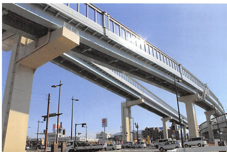
福岡高速 5 号線福重高架橋 (福岡)
