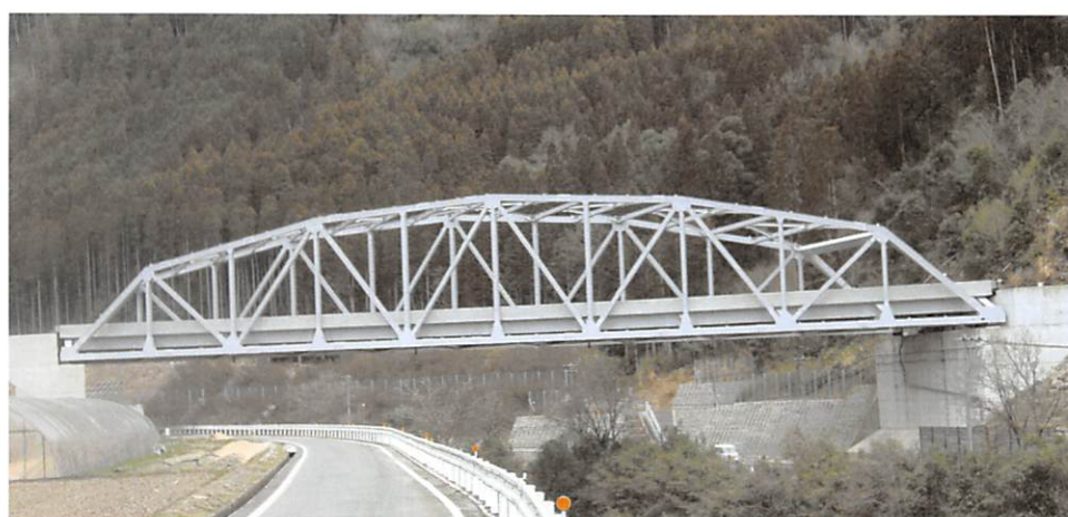
山移橋梁（大分）
